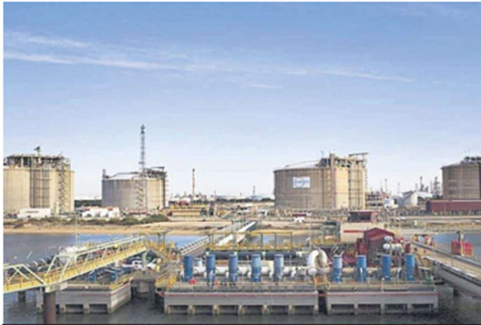
Instalaciones de Enagás desde su escuela en el Puerto de Huelva.
