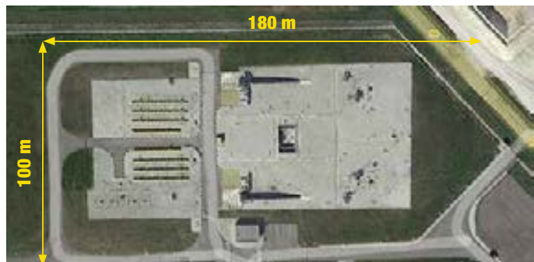
Vista aérea de una estación de válvulas, medición y regulación comparable a la futura estación receptora de BarMar.
