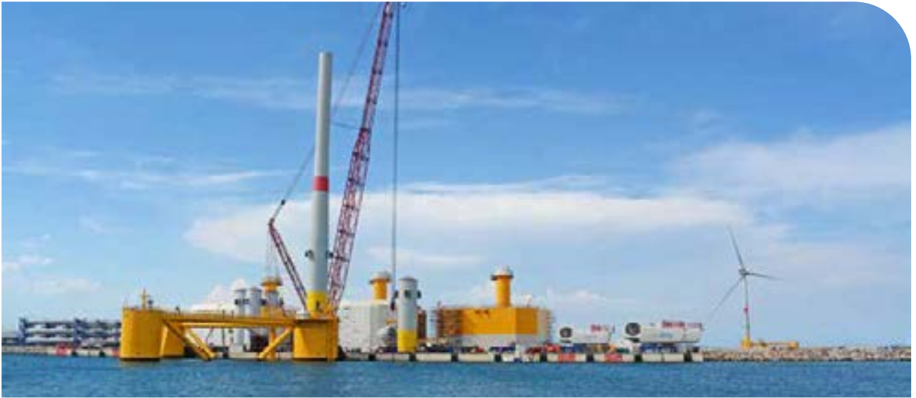
Instalación de aerogeneradores en Port-la-Nouvelle
