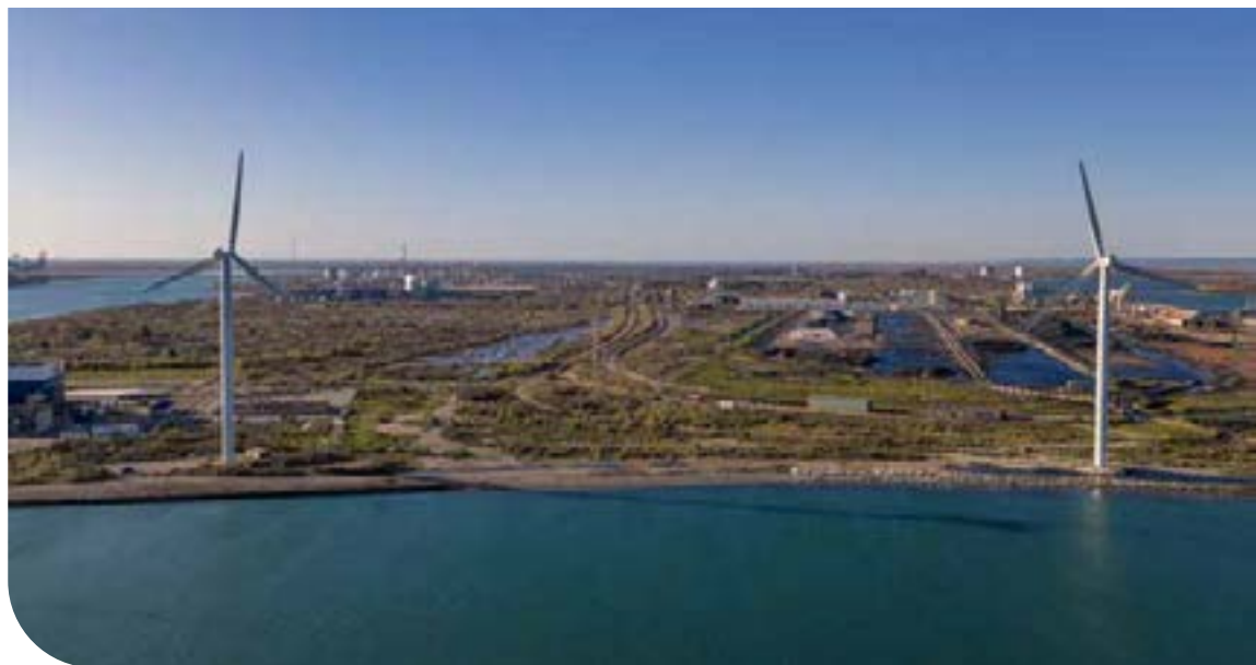
Vista aérea de la zona de llegada a tierra
