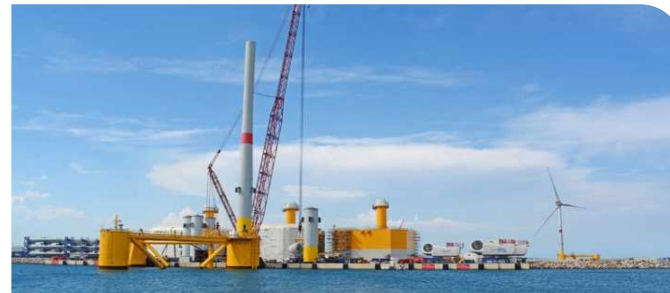
Assemblage d'éoliennes à Port-la-Nouvelle
