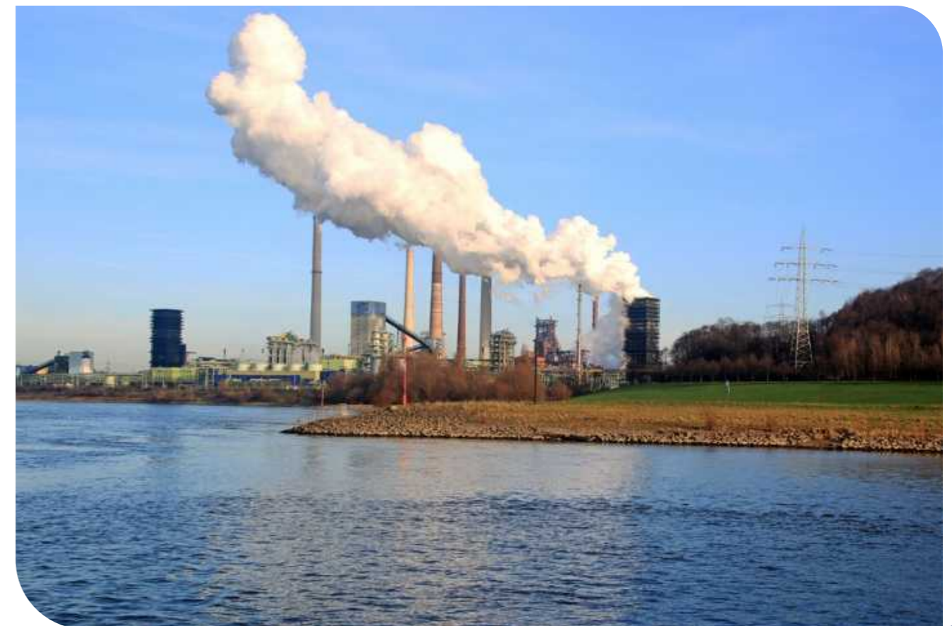
Site industriel à Duisburg (Allemagne)
