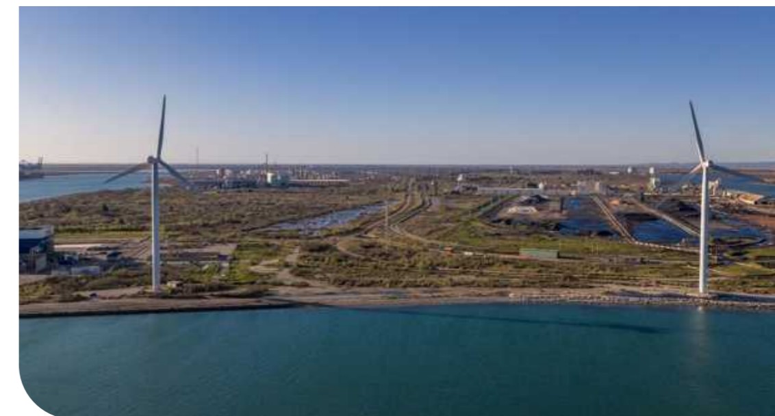
Vue aérienne de la zone d'atterrage
