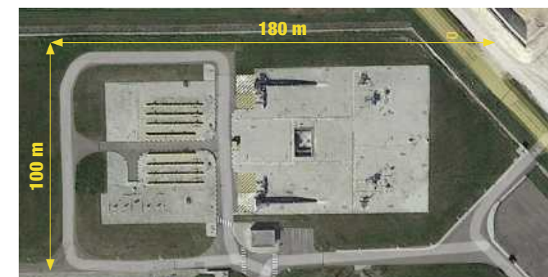
Vue aérienne d'un poste de coupure / comptage / régulation comparable à la future station d'arrivée de BarMar.
