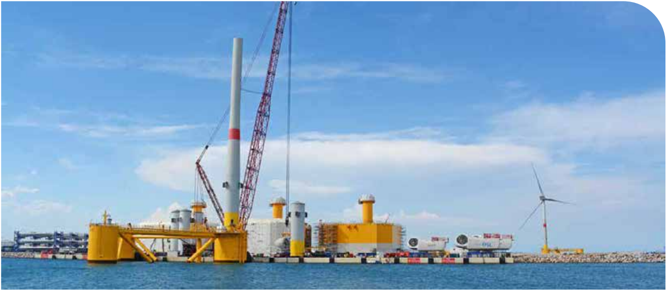
Instal·lació d'aerogeneradors a la Novella
