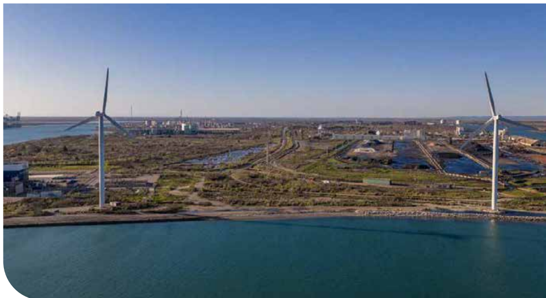
Vista aèria de la zona d'arribada a terra
