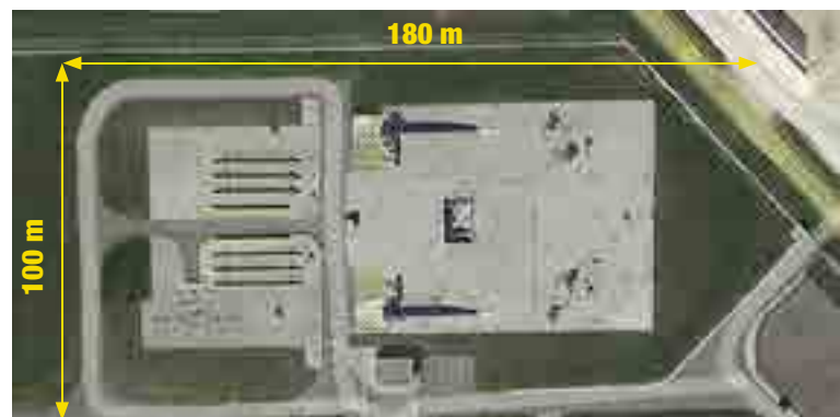
Vista aèria d'una estació de vàlvules, mesurament i regulació comparable a la futura estació d'arribada de BarMar.
