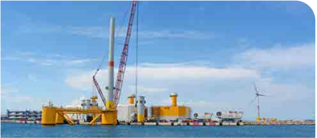
Instal·lació d'aerogeneradors a la Novella
